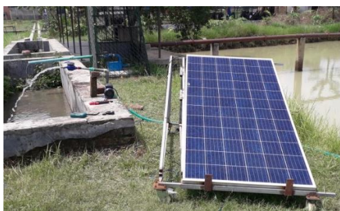
c. Mini solar pump (280W, 40L/min)
